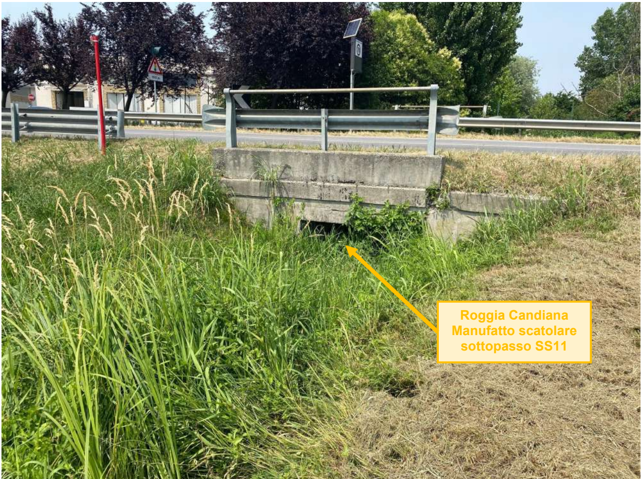
Figura 3 – Roggia Candiana - Manufatto sottopasso SS11 – padana superiore
