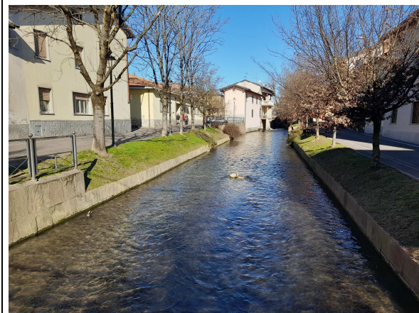
Foto 1: Roggia BG142-011 in corrispondenza del centro abitato.
