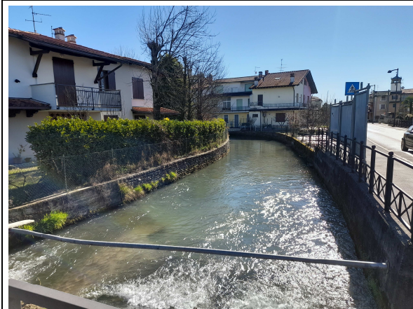
Foto 3: Roggia BG142-011 in corrispondenza di Via Toscanini.
