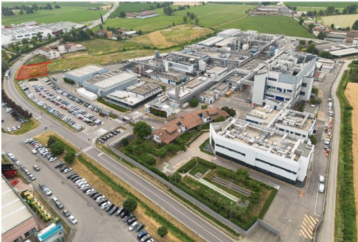
Figura 1.2 Il sito allo stato di fatto
