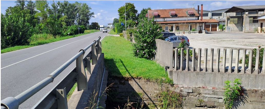
Foto attraversamento ciclabile incrocio con ingresso area produttiva
